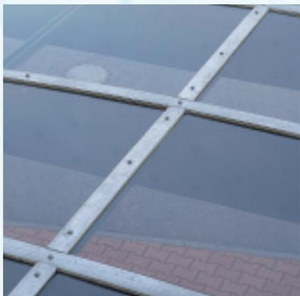
Dachgestaltung wahlweise aus witterungsbeständigem Acrylglas oder verzinkten Stahlblechen nach DIN EN 10 326 NA 275 g/qm, ca. 20 µ Zinkauflage und Pulverbeschichtung auf Epoxid-/Polyesterharzbasis, eingebrannt, ca. 80 µ Farbauftrag. Standardfarbe RAL 9007. Weichgummi Auflage mit Edelstahlprofil 50 mm breit befestigt. Wasserkette bauseits oder optional.
