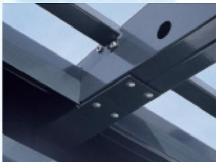
Stützen, Quer- und Längsträger sind aus gekantetem Stahlblech gefertigt. Standardmäßig sind alle Querträger mit Durchmesser 40 mm gelocht. Als Extra ist auf dem Fronträger eine Beschriftung möglich.
