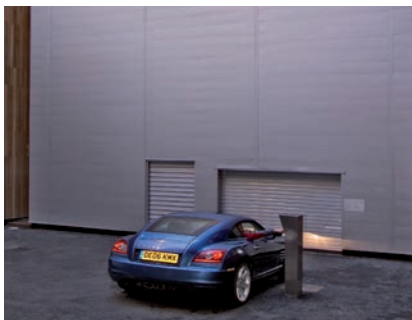
01 Im Innenhof befindet sich die Einfahrt zum Parksafes 583, der auf einer Grundfläche von nur ca. 10 m x 18 m und bei einer Gesamthöhe von 21 m 84 Stellplätze auf 10 Ebenen bietet.
