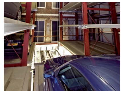
12 Ein Blick von innen zur Gebäudefassade: Die Stahlkonstruktion vom Parksafe sichert und stabilisiert die denkmalgeschützte Fassade.
