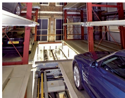
11 Nachdem der Vertikallift die angewählte Lagerebene erreicht hat, zieht das Shuttle die Parkpalette aus dem Lagerfach.
