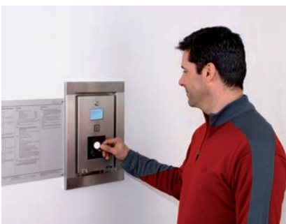
10 Zur Ausfahrt wählt der Fahrer seinen Pkw im Warte- teraum berührungslos mit seinem Transponder an.
