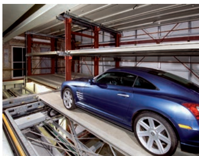
08 Nach dem Erreichen des vorgesehenen Lagerfachs wird die belegte Parkpalette bei der zweireihigen tiefen Anordnung mit der dahinterliegenden Parkpalette gekuppelt und vom Shuttle in das Lagerfach geschoben.
