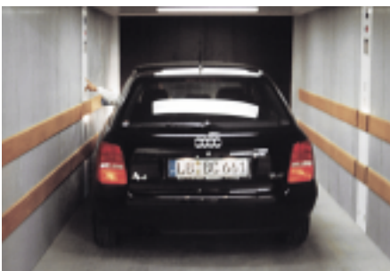
Die Bedienung erfolgt am Kommandotaster an der linken Fahrkorbwand.
