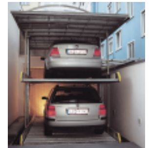
Bei der Renovierung einer Apotheke in der Innenstadt von Stuttgart sollten 5 Stellplätze in einer ca. 3 m breiten und 20 m langen Hofeinfahrt geschaffen werden. In die Zufahrt wurde eine Versenkgarage Parklift 462 für 2 Pkw eingebaut, bodenbündig und überfahrbar. Dahinter ein Parklift 413 für 3 Pkw.
