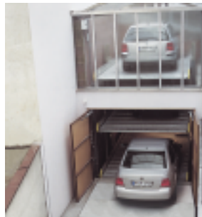
Bei der Renovierung einer Apotheke in der Innenstadt von Stuttgart sollten 5 Stellplätze in einer ca. 3 m breiten und 20 m langen Hofeinfahrt geschaffen werden. In die Zufahrt wurde eine Versenkgarage Parklift 462 für 2 Pkw eingebaut, bodenbündig und überfahrbar. Dahinter ein Parklift 413 für 3 Pkw.
