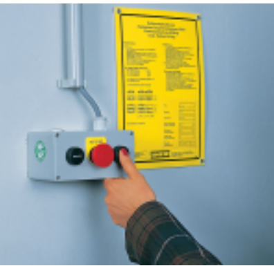
Am Bedientableau wird die Parkplatte per Drucktaster mit Rechts/Links-Pfeilen in die gewünschte Richtung verschoben. Läßt man den Taster los, bleibt die Parkplatte stehen.
