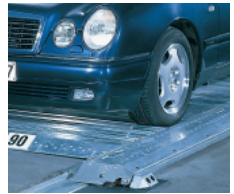
Die »Plattformnase« zeigt den bodenbündig montierten Unterflurantrieb und die Parkplattenlängenbegrenzung. Die Verwendung von Gußasphalt erfordert eine spezielle Konstruktion und Befestigung der Laufschiene, um die Wärmeeinleitung des Gußasphalts auszugleichen.
