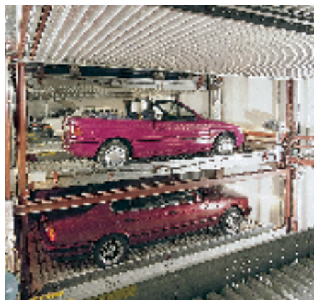
Durch Heben und Senken und seitliches Verschieben kann jedes Fahrzeug innerhalb von 1 Minute zum Ausfahren bereitgestellt werden.
