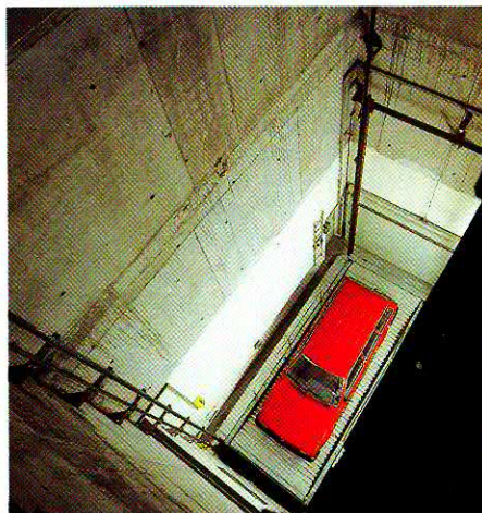
Auto im Aufzug: Selbst bei Ausfall des Aufzugmotors kann es immer noch befördert werden
