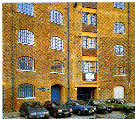
"Miller's Wharf" ist ein ehemaliges viktorianisches Speicherhaus
