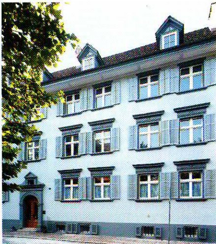
Fassade des Hauptbaus
