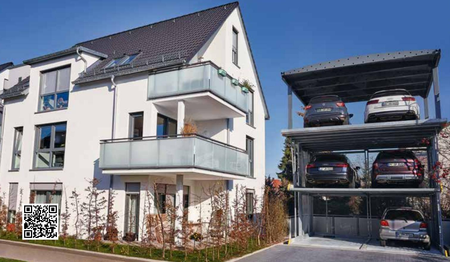
Der **WÖHR Parklift 462** als Doppelanlage bietet 4 unterirdische Stellplätze. Das System wird bodenbündig abgesenkt. Mit hochwertigem Teakholz, Stein-
