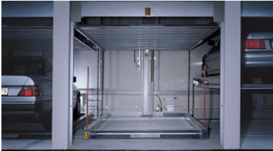
den EG-Plattformen. Für das Heben bzw. Senken sorgt ein rückwärtig in der Mitte jedes Stellplatzes angeordneter Hydraulikzylinder, der die Plattform über Gleichlaufketten waagrecht bewegt. Die meisten Systemteile sind verzinkt, Schweißkonstruktionen pulverbeschichtet.
