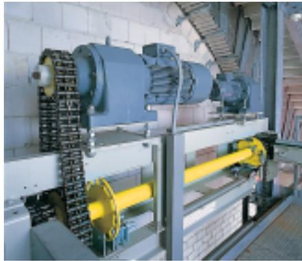
Ein 30kW starkes Antriebsaggregat erreicht eine Fördergeschwindigkeit von 48m/min. Die Zugriffszeiten liegen im Projekt Hauptstraße zwischen ca. 85 – 165 Sekunden. Ein Notantriebsaggregat hilft bei einem eventuellen Ausfall, Fahrzeuge zu befreien.
