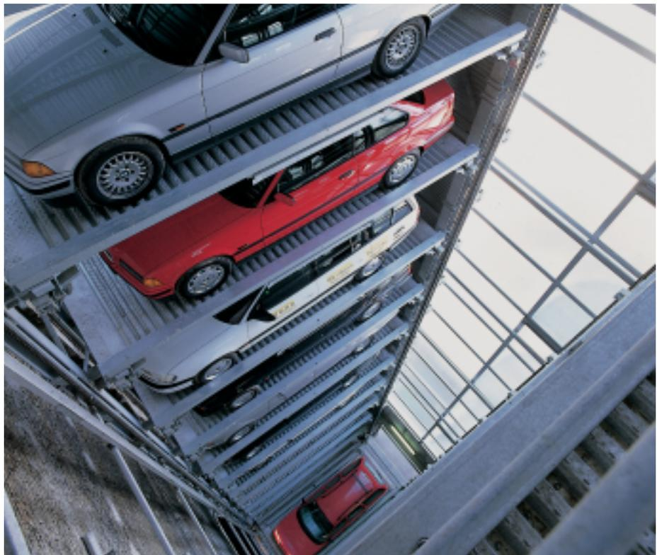
Ein Blick aus 25 m Höhe in den Förderschacht zeigt die Glasfassade, den Vertikalförderer und die seitlich angeordneten Regalfächer, in denen Fahrzeuge bis 2,5 t geparkt werden können.
