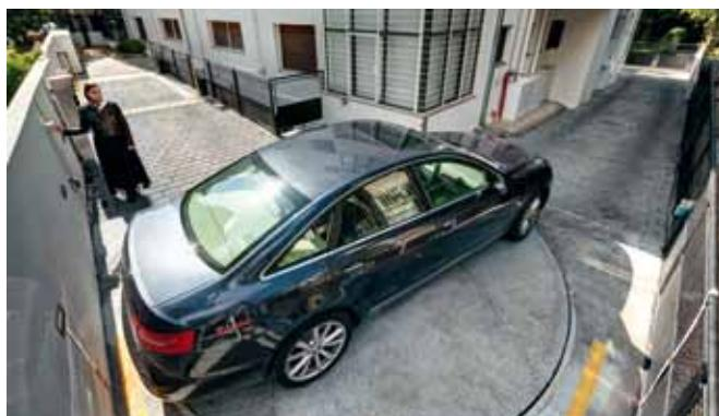
Um die schmale Kurve von nur drei Metern hinter dem Haus zu bewältigen, wird das Auto auf einer Drehscheibe um die Ecke geschwenkt.
