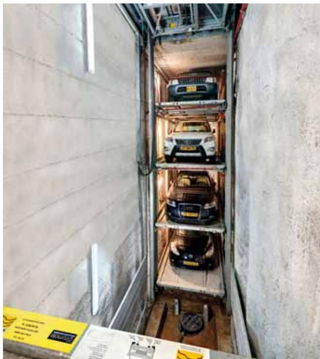
Voll automatisch wird das Fahrzeug beim Slimparker vertikal in die schmale unterirdische Garage herabgelassen und eingeparkt.
